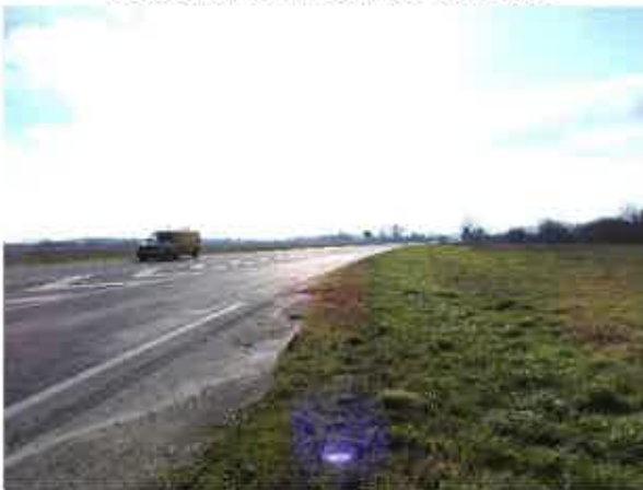
Vue depuis l'accès au projet sur le sud et la R.D.820, limitée par la ripisylve du Crieu
