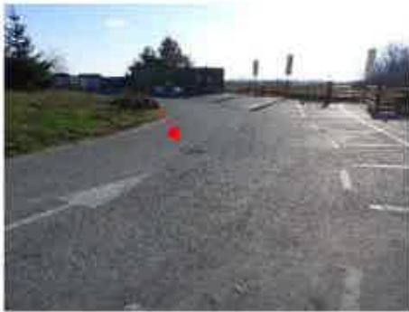
Avaloir du réseau d'eau pluviale
