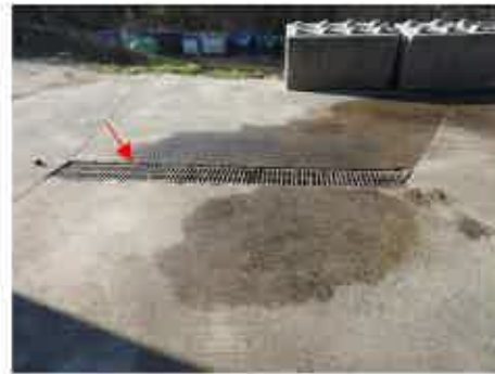
Avaloir du réseau d'eaux souillées
